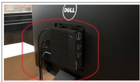
Thin Client (situado detrás del monitor)
